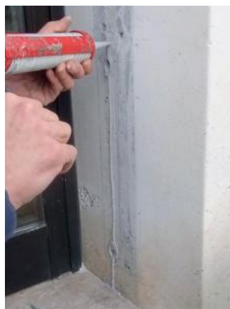
10 Im Bereich der Montagefläche Silikon auftragen
