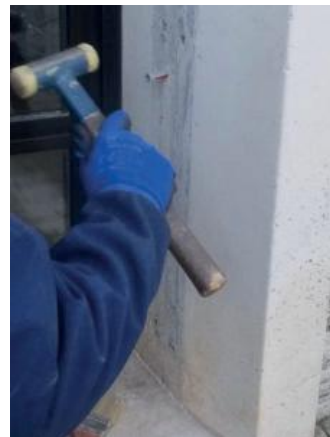
9 Die Dübel einsetzen.
