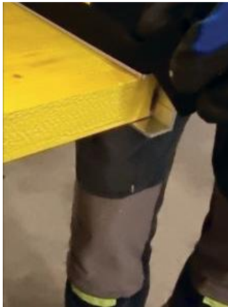
11 Die Kante des Seitenwinkels unter der Dichtung mit der Schalttafel ausrichten.
