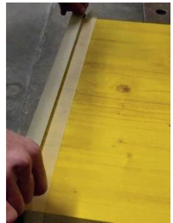
15 Kleben Sie die Seitenwinkel mit Kreppband ab. Kleben Sie Kreppband mit einem Abstand von 5mm zum Seitenwinkel auf die Schalttafel
