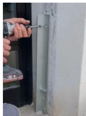
13 Die Eckwinkel an der Wand anschrauben.
