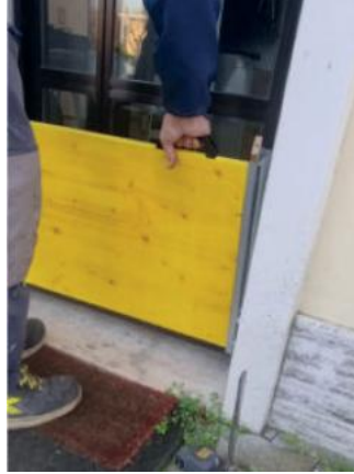
2 Die Wasserschutzwand in die Öffnung einsetzen.
