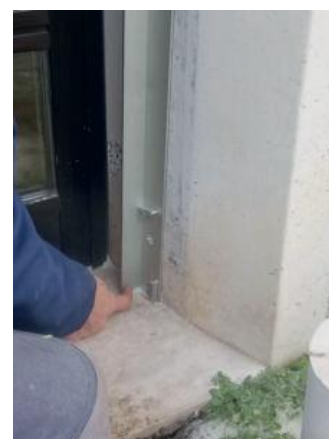
14 Das überschüssige Silikon entfernen.
