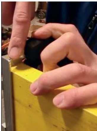
14 Das überschüssige Silikon, das unter dem Dichtungsband austritt, entfernen.
