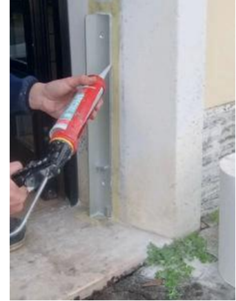
18 Mit Silikon die Ecke des Winkels abdichten
