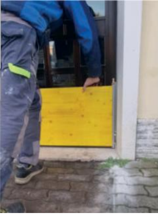
16 Die Montageposition der Wasserschutzwand prüfen.
