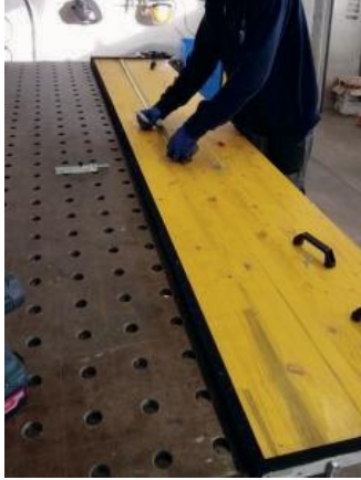
30 Messen Sie unten die Mitte der Wasserschutzwand.
