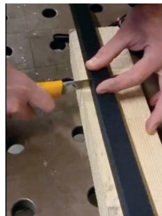
21 Die Dichtung mit einem Cutter und neuen Klingen vorsichtig im Winkel von 90° zuschneiden.
