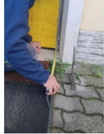
3 Die Wasserschutzwand in der gewünschten Lage positionieren.
