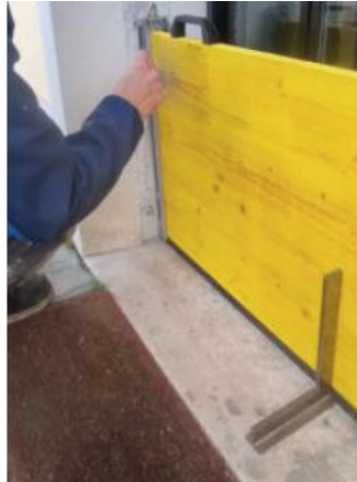
5 Die Position der Eckwinkel markieren.
