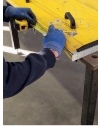
32 Die Positionen der Griffe jeweils 200 mm von der Außenkante markieren.
