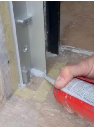
19 Eine Silikonraupe am Fuß des Eckwinkels setzen
