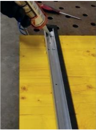
7 Vor dem Aufsetzen der Seitenwinkel links und rechts im Winkel eine Silikonraupe legen. Hierbei auch die Bohrungen der Nieten versiegeln
